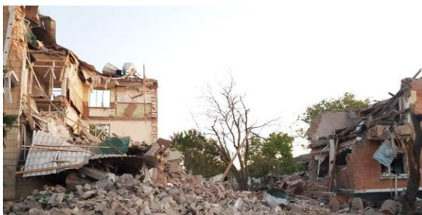
Внаслідок обстрілів зруйновано багатоквартирні будинки (Фото:НПУ)
