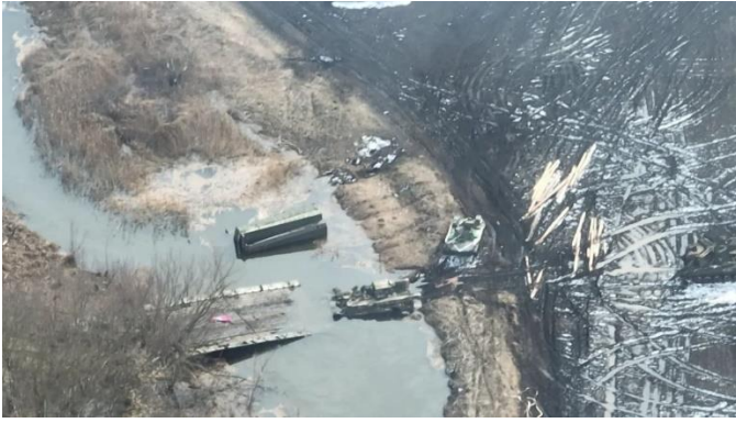
Знищена російська понтонно-мостова переправа через р. Ірпінь Фото – Махар Tevhnologies
